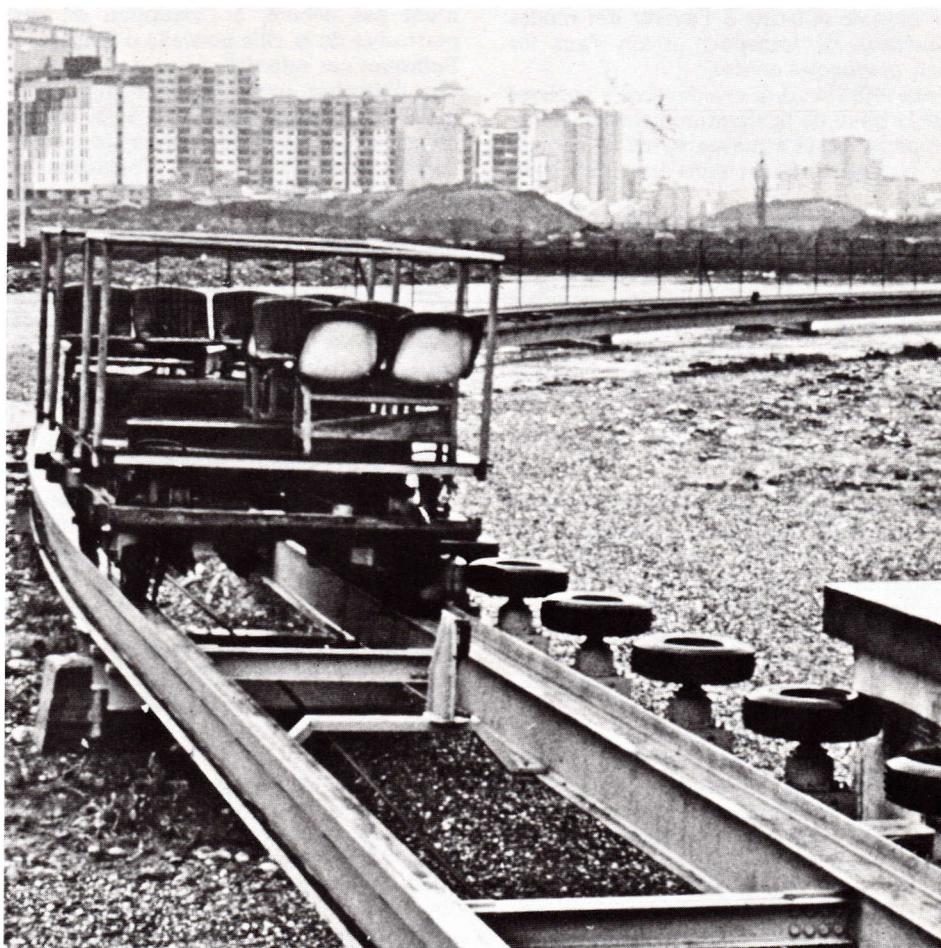
Le véhicule du système POMA 2000, avec ses tourets d'accélération et de décélération, sur la piste d'essai de Grenoble.
