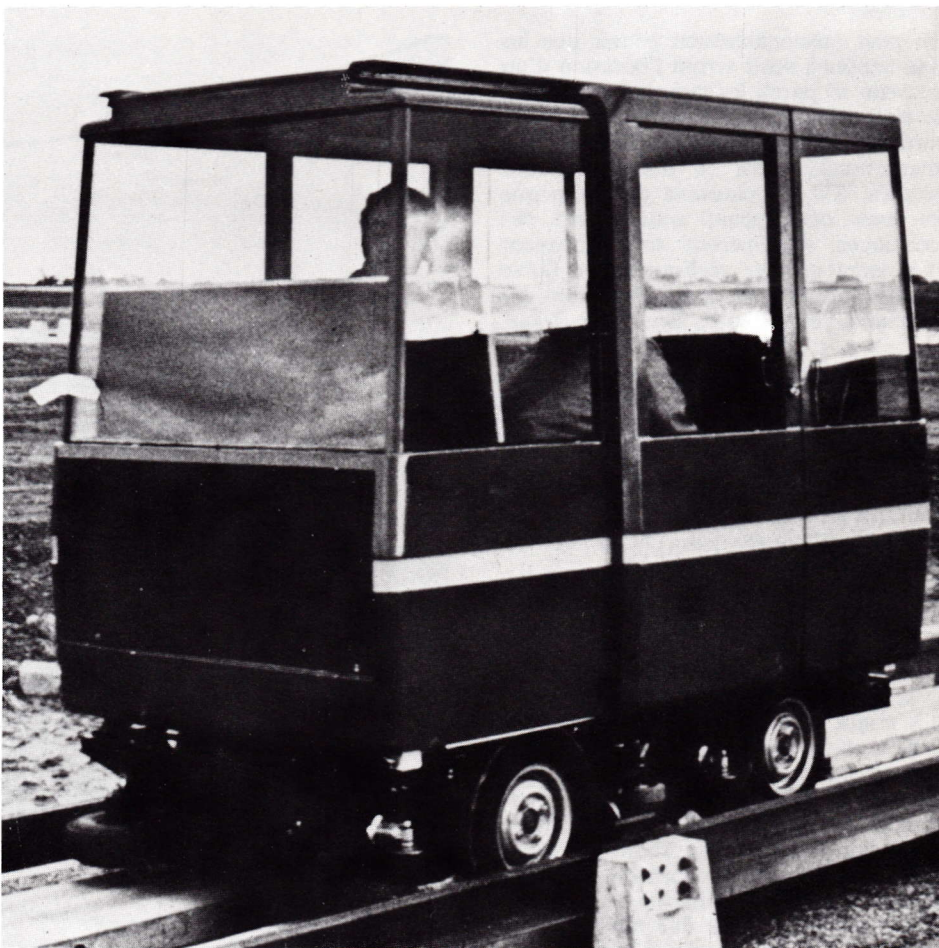
Aramis, système de transport en site propre, entièrement automatique, expérimenté sur le site de l'aéroport d'Orly depuis 1973 : vitesse moyenne 50 km/h, 15 000 passagers à l'heure.
