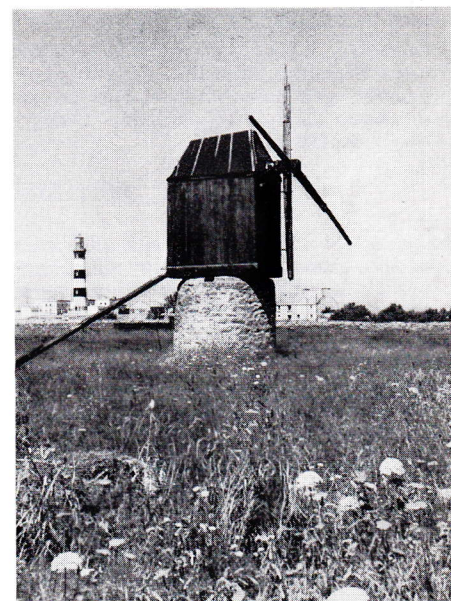
Moulin à Ouessant
