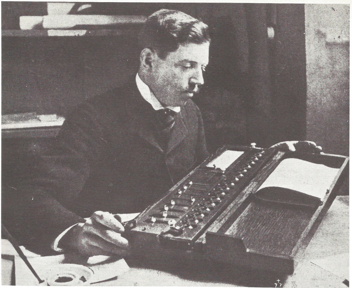
Arithmomètre Thomas. Première machine capable d'exécuter rapidement les quatre opérations fondamentales de l'arithmétique.
